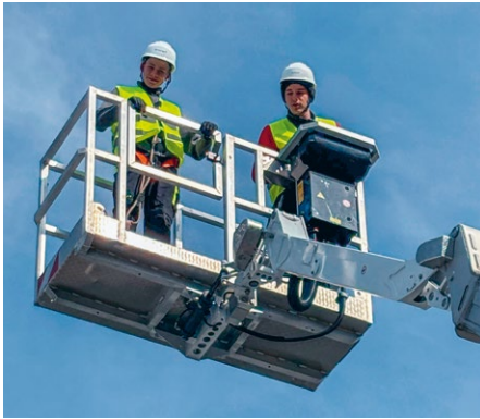
Hoch hinaus ging es bei der ETAVIS Elcom AG. Hier erhielten die Jugendlichen Einblicke in die Berufe Elektroinstallateur/-in und Montage-Elektriker/-in.
