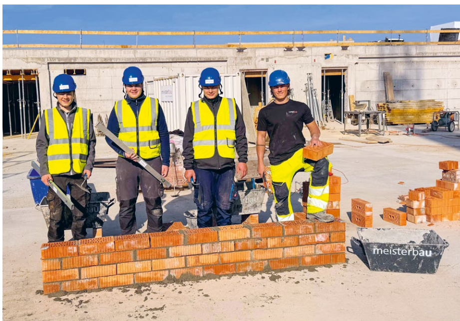
Bei der Meisterbau AG in Balzers erhielten die Jugendlichen Einblicke in die Berufe Maurer/-in und Baupraktiker, wo sie selber anpacken, gestalten und sehen konnten, was entsteht.
