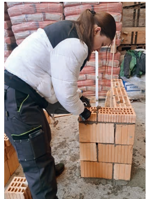
Diese junge Dame erkundet den Beruf der Maurerin und konnte bei der Meisterbau AG bereits ihre erste Ziegelwand errichten.
