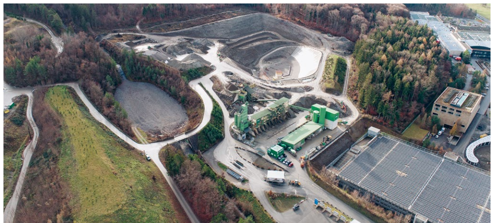
Abbildung 1: Luftbild Bauabfallkompartiment und Kieswerk mit Recyclinganlage auf der Deponie Forst in Schaan.
