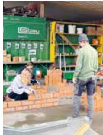
Bei der Gebr. Hilti AG in Schaan wurden von den interessierten Schülern bereits erste Mauern erstellt.
