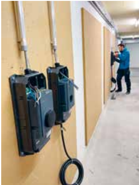
LKW-Mitarbeiter bei der Montage der Ladestationen.
