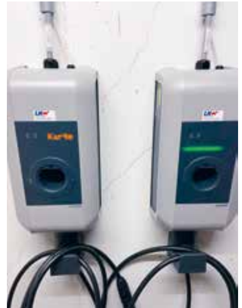
Sechs Ladestationen mit 32A Ladeleistung.
