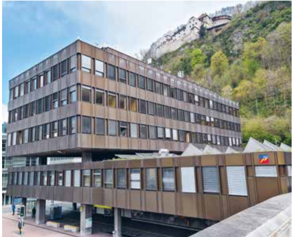
Post- und Verwaltungsgebäude Vaduz
