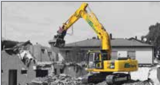
Abbruch- und Aushubarbeiten
