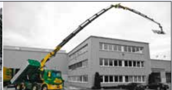
Kranarbeiten bis RW 44 m
