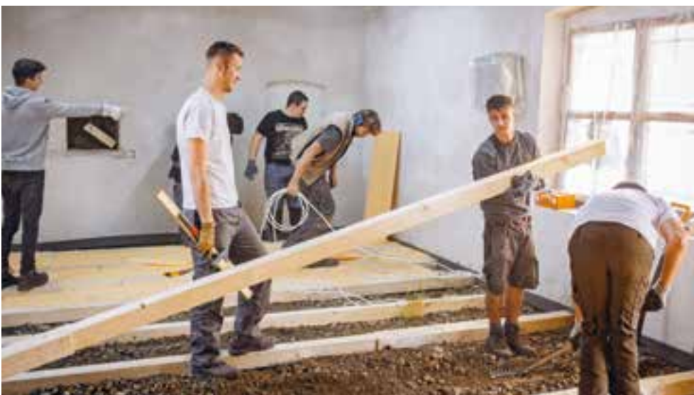
In der Schreinerei entsteht der Fussboden.
