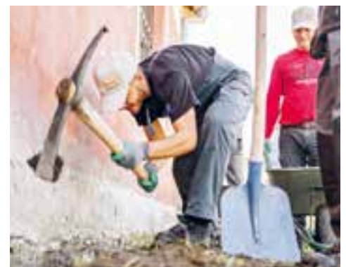
Omer Music beim Erstellen der Sickerleitung.
